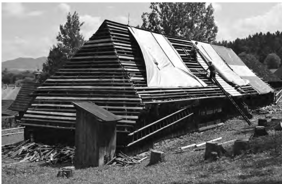
Obr. 4, 5. Kladenie novej šindľovej krytiny na strechu usadlosti z Novote a obytného domu usadlosti z Hruštína. Foto J. Neplech, 2018
