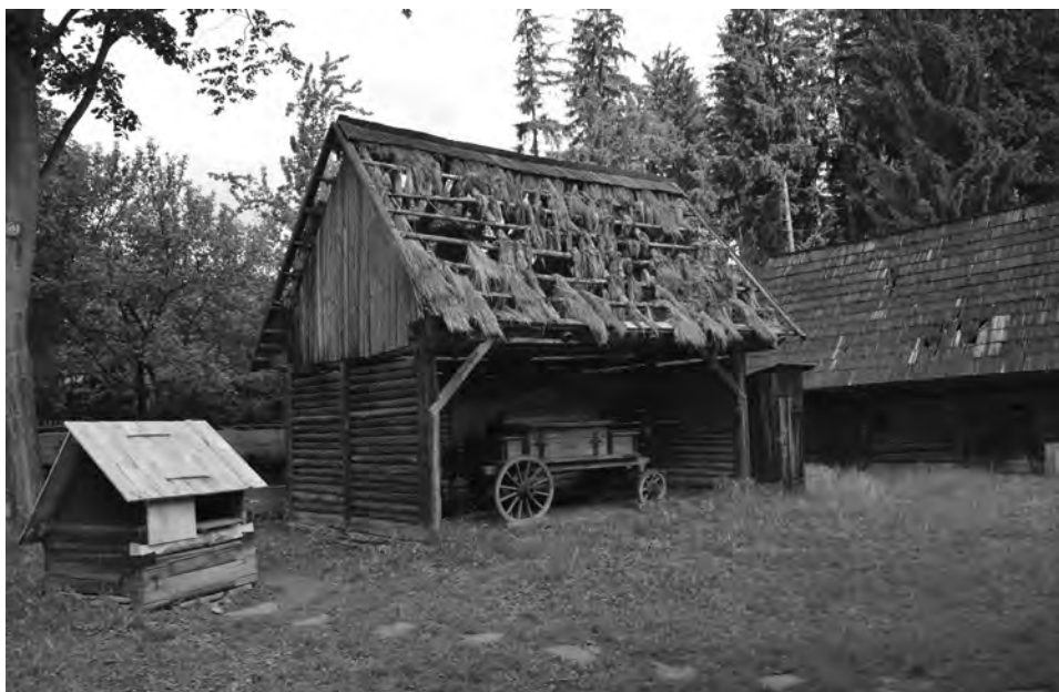
Obr. 1, 2. Otvorený prístrešok a združená hospodárska stavba usadlosti z Vyšného Kubína pred a po rekonštrukcii. Foto R. Sýkora, 2018
