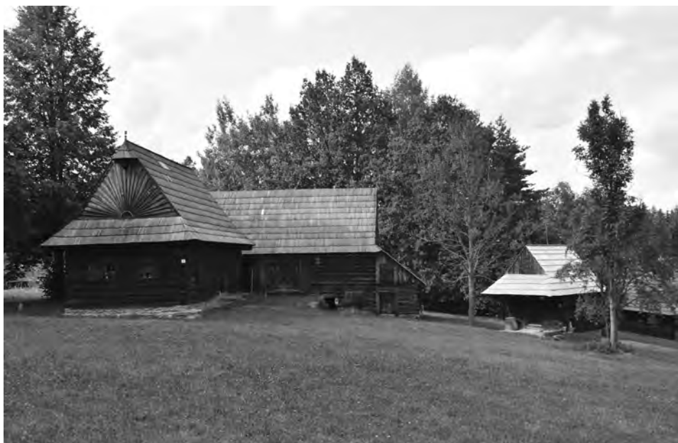
Obr. 13, 14. Usadlosť zo Zázrivej, celkový pohľad a zvonkárská dielňa pred výstavbou nového ohniska, čelný pohľad, v Múzeu slovenskej dediny. Foto R. Sýkora, 2018
