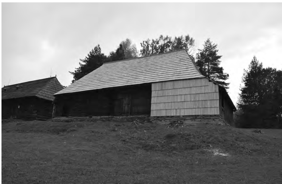
Obr. 7. Stodola usadlosti z Oravského Veselého po rekonštrukcii. Foto J. Neplech, 2018 Fig. 7. Barn of the farmstead from Oravské Veselé after reconstruction. Photograph by J. Neplech, 2018
