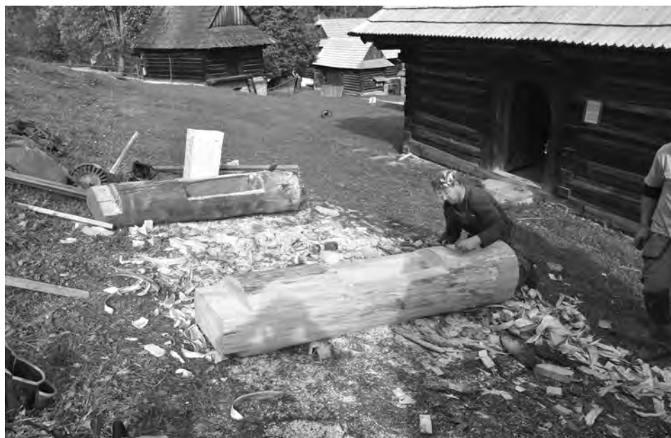
Obr. 6. Výroba zvislej stojky počas opráv baranového lisu v objekte olejárne. Foto J. Neplech, 2018 Fig. 6. Production of a vertical post during the repair of the press in the oil-making building. Photograph by J. Neplech, 2018
